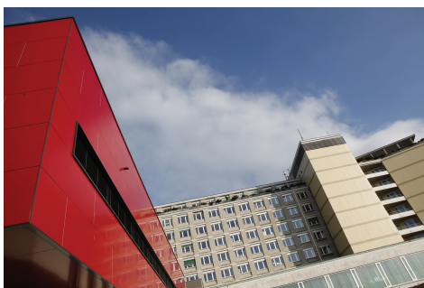
Das HFR Freiburg- Kantonsspital, eines der sechs Spitäler des Spitalverbundes HFR
